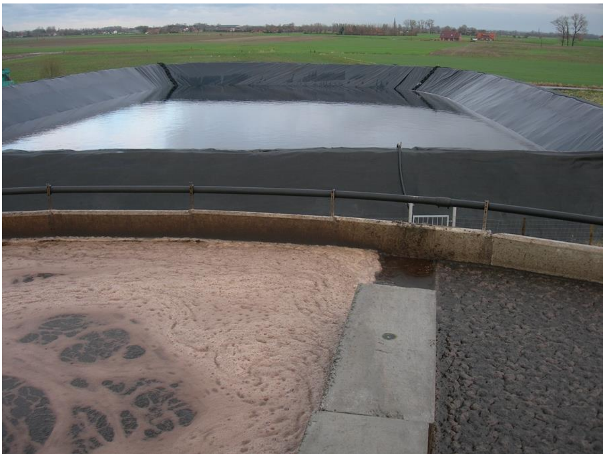
Figuur 1 Op deze figuur is de biologie (vooraan) en de effluentopslag (achteraan) zichtbaar.
