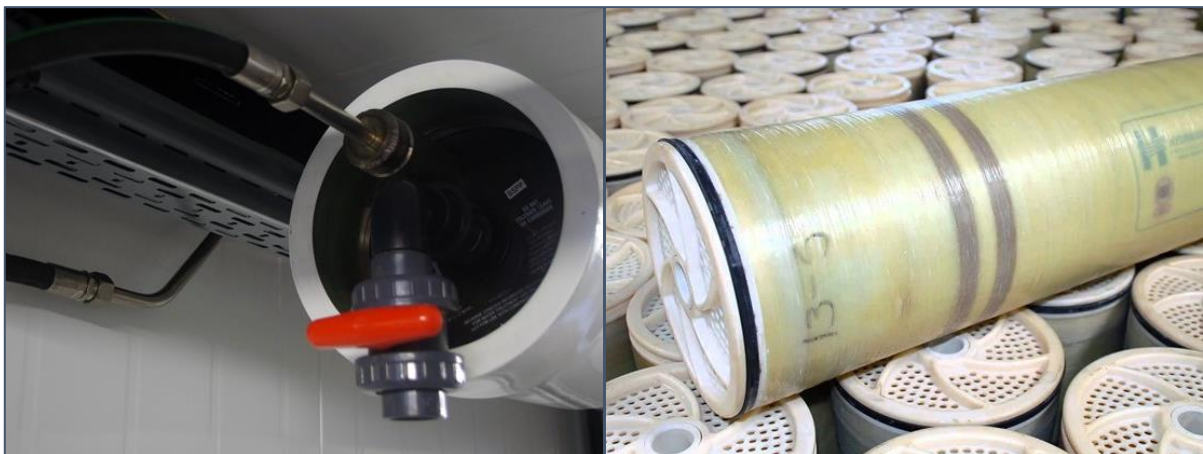
Figuur 6: Foto van de omgekeerde osmose aan de buitenkant (links) en de binnenkant (rechts).
