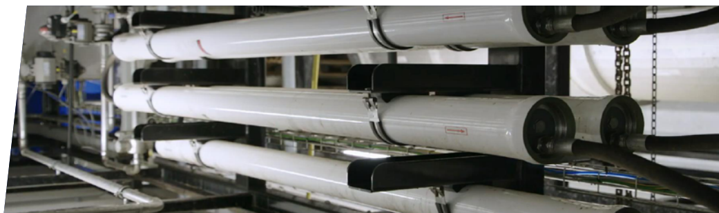
Figuur 5: Operationele installatie met membraanfiltratie (RO).
