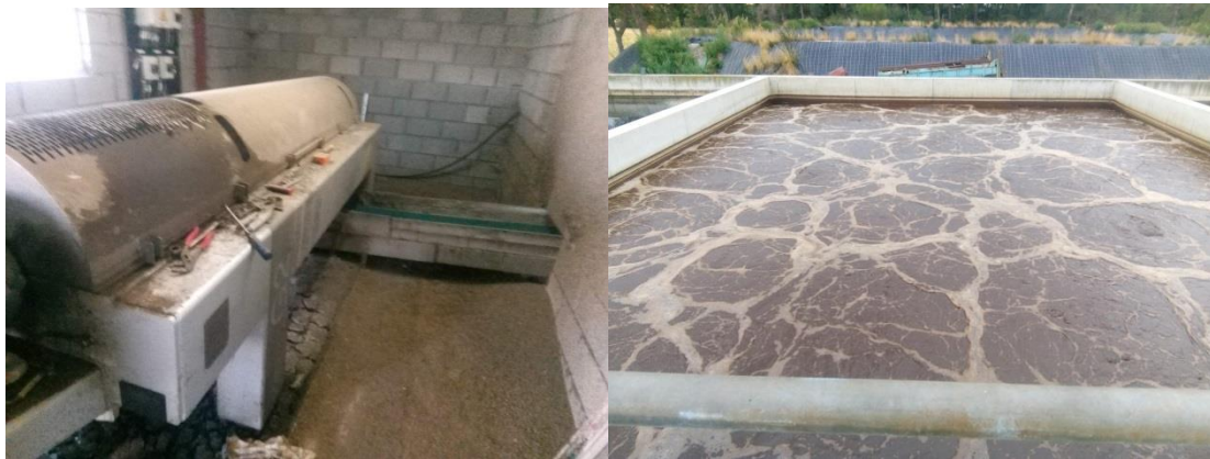
Figuur 2 Links: centrifuge bij V2, rechts: beluchtingstank voor dunne fractie.
