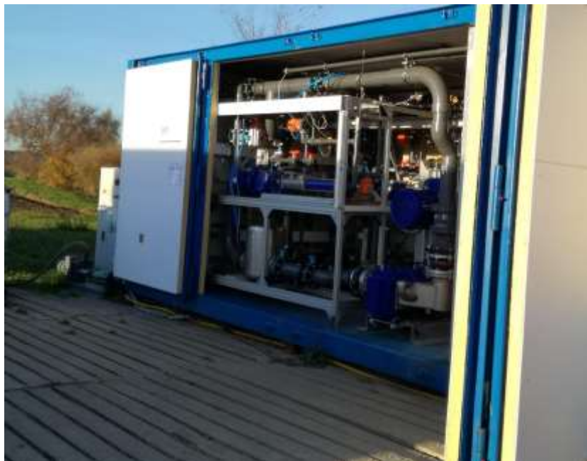
Demo-installatie te Kupferzell
