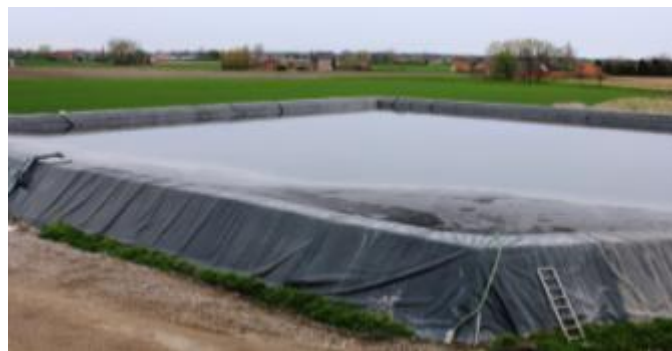
Figuur 4: Effluentbekken met folie over buitentalud.
