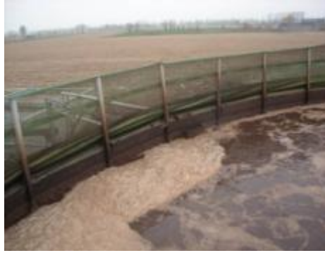
Figuur 3: Windbreekgaas op nitrificatiebekken.
